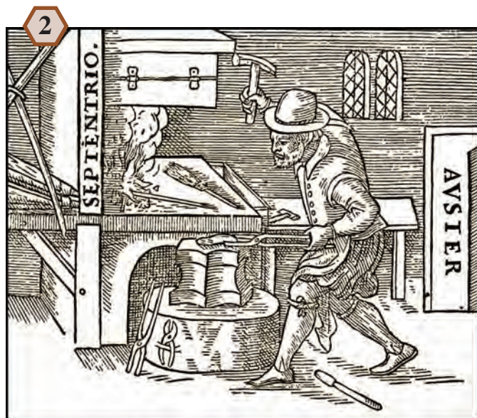
En chauffant au rouge un morceau de fer aimanté, ce forgeron de la Renaissance lui enlève sa force d'attraction magnétique.
