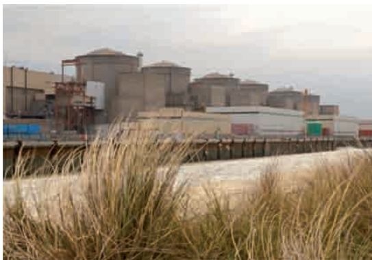
Centrale nucléaire de Gravelines (6 × 900 MWe – 150 ha).
