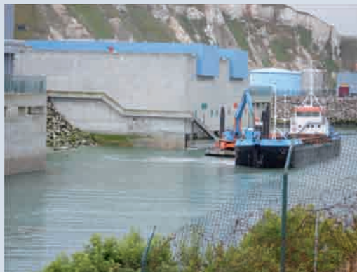
Opération de dragage à la centrale nucléaire de Penly.
