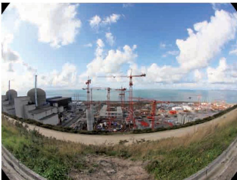
Centrale nucléaire de Flamanville (EPR en construction) sur la Manche (120 ha).
