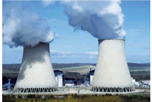
Aéroréfrigérants : Centrale nucléaire de Nogent/Seine.
