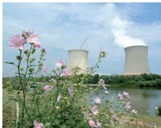
Centrale nucléaire de St-Laurent-des-eaux sur la Loire (60 ha).
