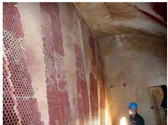
Plaque tubulaire de condenseurs.
