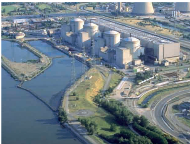
Centrale nucléaire de Tricastin sur le Rhône en circuit ouvert (55 ha).
