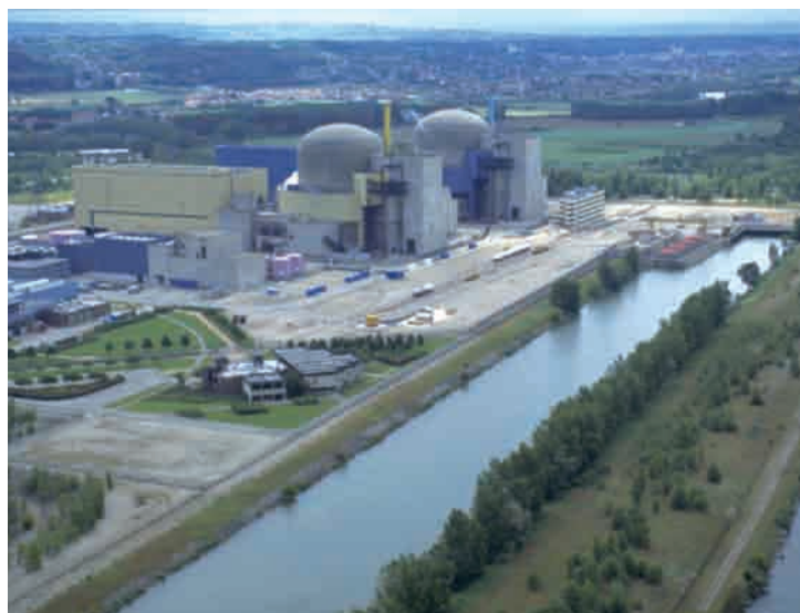
Centrale nucléaire de St-Alban sur le Rhône (2 × 1300 MWe – 180 ha).
