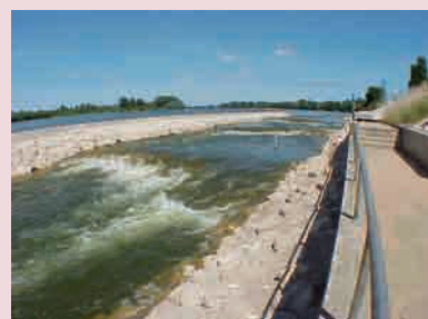
Passe à poissons à la centrale de St-Laurent-des-eaux
