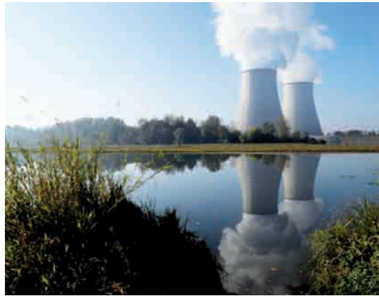
Centrale nucléaire de Belleville sur la Loire (2 × 1300 MWe refroidie en circuit fermé - 165 ha).
