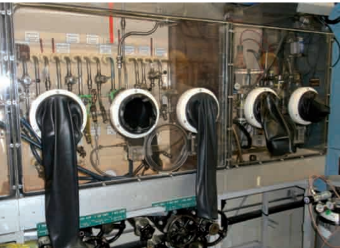
Hotte d'échantillonnage du circuit primaire : centrale nucléaire du Bugey
