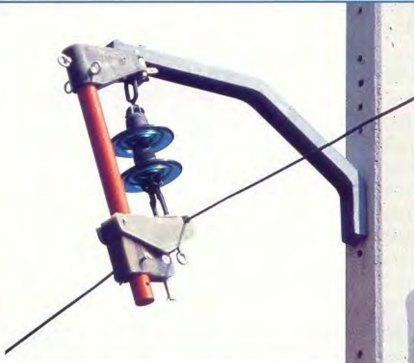
Tirant d'alignement pour câbles électriques. Matrice : EP. (Travail sous haute tension.) Renfort : FV.
